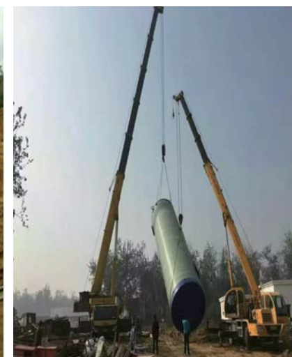
通辽开鲁污水处理厂泵站 日处理量：20160m³/D 泵站规格：DN3800*7820
