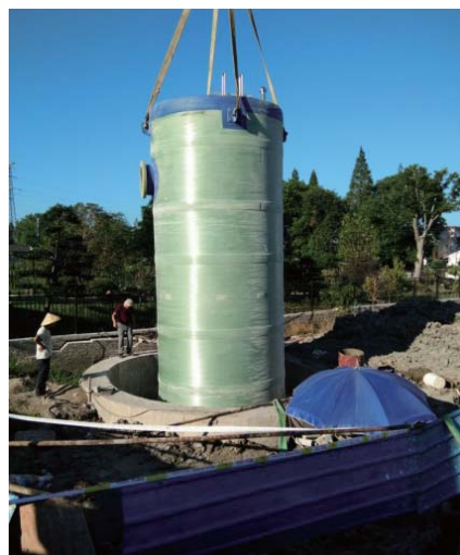
芜湖六郎泵站 日处理量：4560m³/D 泵站规格：DN3000*7300
