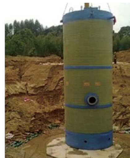
汕头饶平污水处理厂泵站 日处理量：16100m³/D 泵站规格：DN3800*9900
