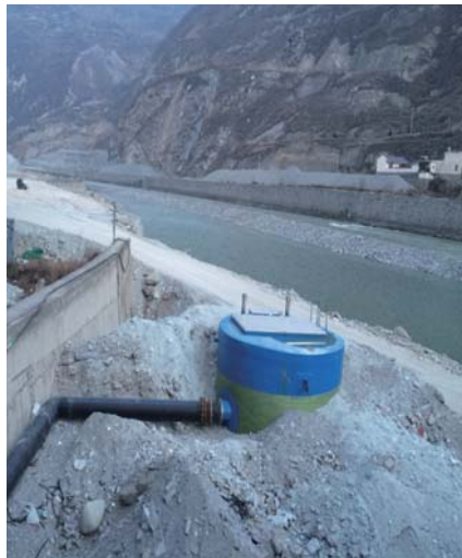
晋城黑臭水整治 日处理量：7680m³/D 泵站规格：DN3000*5930
