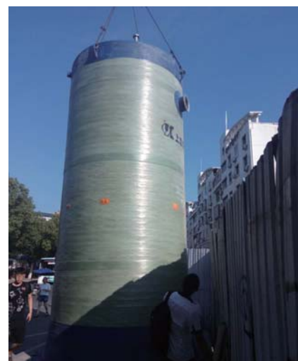
廊坊常宁路泵站 日处理量：8200m³/D 泵站规格：DN3000*7200
