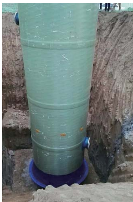
河南鹤壁开发区 日处理量：2000m³/D 泵站规格：DN2000*7700
