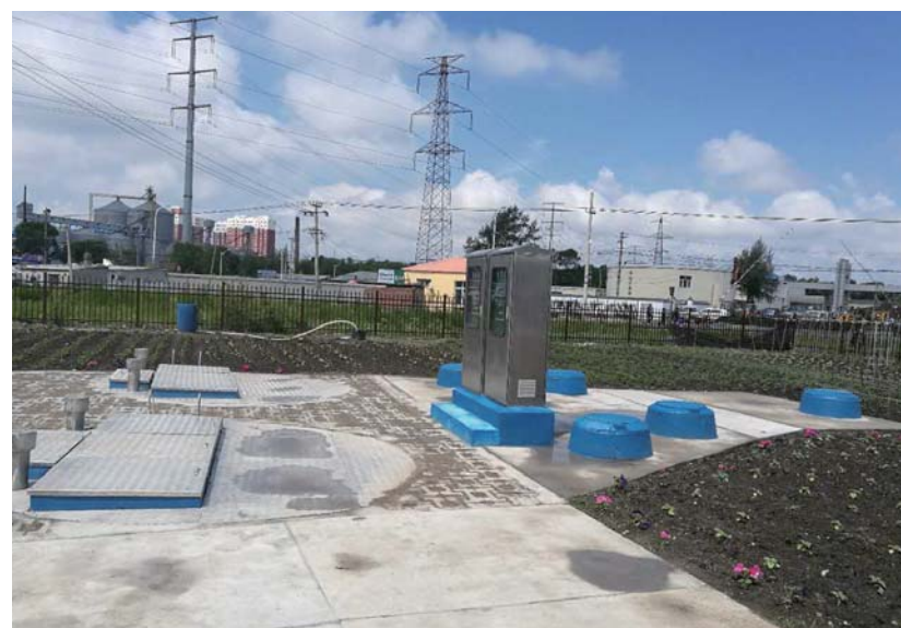
佳木斯达音木河泵站 日处理量：86400m³/D 泵站规格：DN3800*8200
