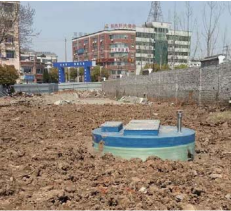
肥西上派小区泵站 日处理量：9600m³/D 泵站规格：DN3000* 4300
