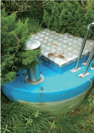
珠海成益组泵站 日处理量：530m³/D 泵站规格：DN1500*3200
