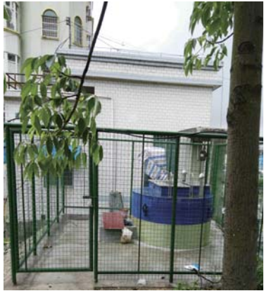
珠海东风组泵站 日处理量：530m³/D 泵站规格：DN1500*3200
