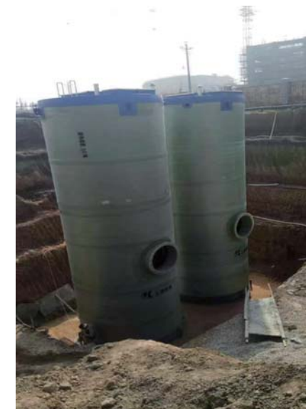
安阳文峰区泵站 日处理量：240000m³/D 泵站规格：DN3800*11420
