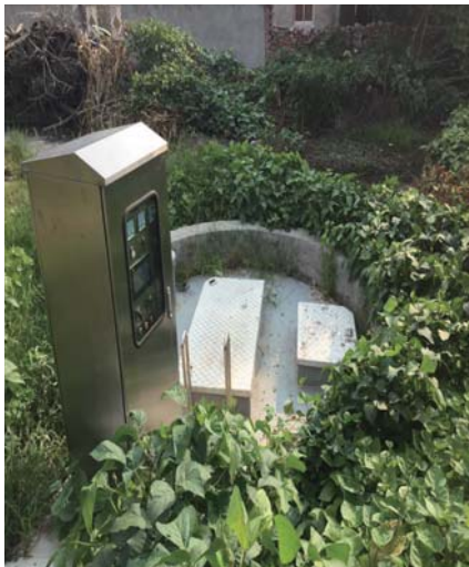
杭州名弘泵站 日处理量：480m³/D 泵站规格：DN1600*3000
