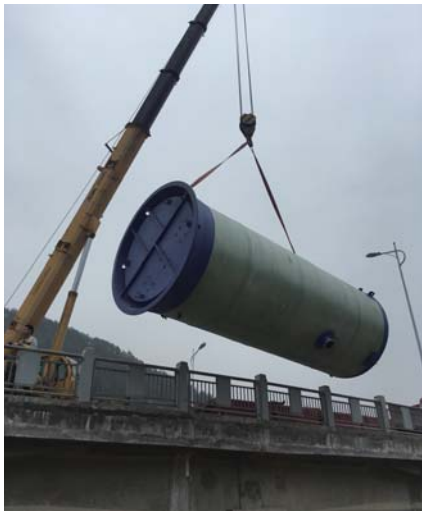
福州坂东泵站 日处理量：4200m³/D 泵站规格：DN3000*5500
