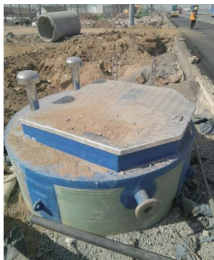
临沂北京东路泵站 日处理量：8640m³/D 泵站规格：DN2000*7400
