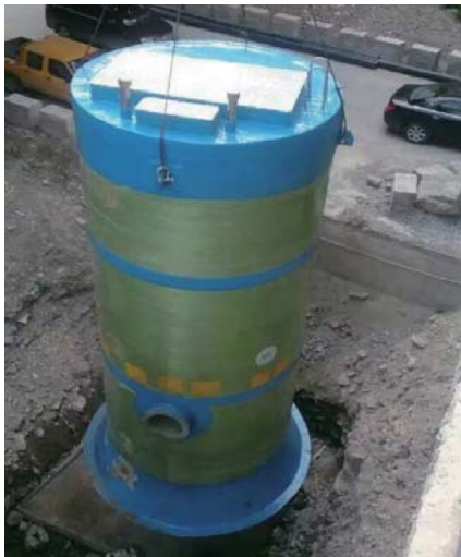
汶川高速隧道泵站 日处理量：14400m³/D 泵站规格：DN3500*7500
