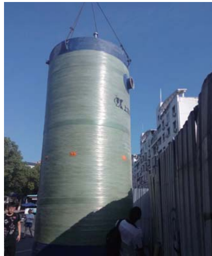
义乌西河生态修复 日处理量：4800m³/D 泵站规格：DN3000*7000
