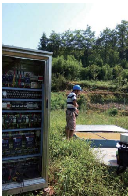
重庆中佳泵站 日处理量：17280m³/D 泵站规格：DN3800*5950
