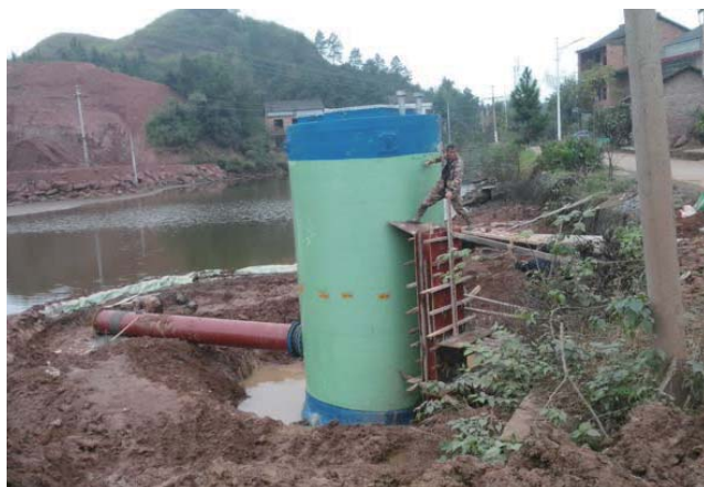
威湿地公园泵站 日处理量：7600m³/D 泵站规格：DN3000*7000
