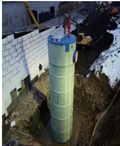
松原成吉思汗大街泵站 日处理量：32000m³/D 泵站规格：DN3800*7700
