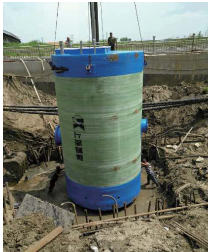
下穿京港澳铁路泵站 日处理量：43200m³/D 泵站规格：DN3800*10220
