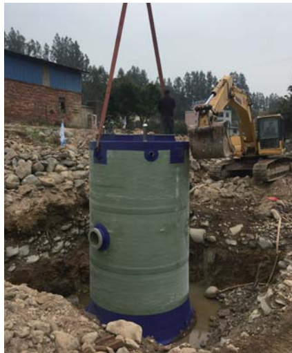
常州春江泵站 日处理量：2400m³/D 泵站规格：DN2000*3530
