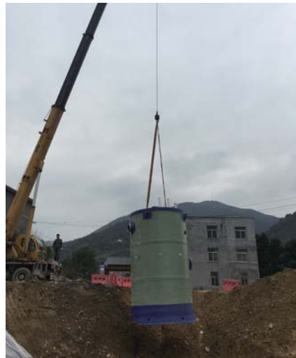
南阳安棚泵站 日处理量：300m³/D 泵站规格：DN1600*3200
