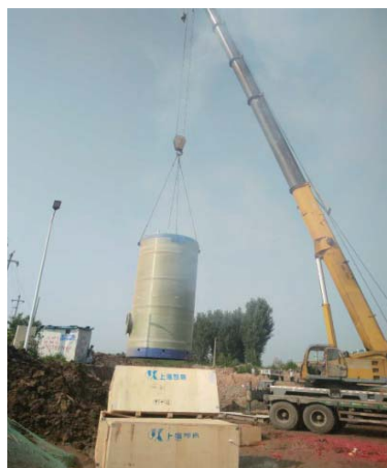
郑州华翔路泵站 日处理量：17640m³/D 泵站规格：DN3000*12030
