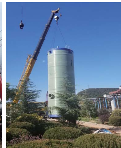
大连高新区泵站 日处理量：9600m³/D 泵站规格：DN3000*8460
