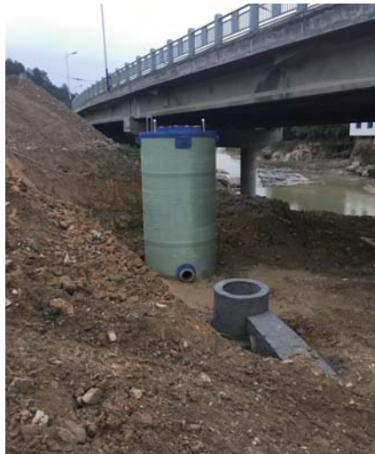
下穿京广铁路泵站 日处理量：86400m³/D 泵站规格：DN3800*10560
