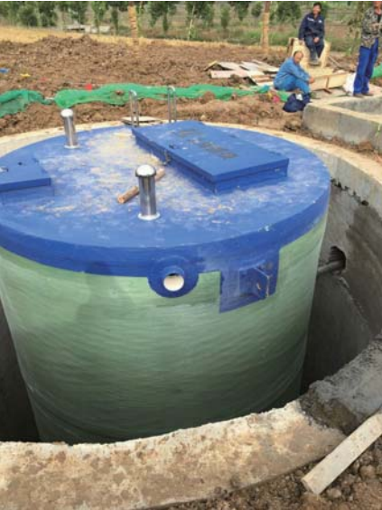
肥东高塘泵站 日处理量：1050m³/D 泵站规格：DN3800*7600
