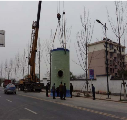
铜陵雨花小区泵站 日处理量：5200m³/D 泵站规格：DN3000*6200
