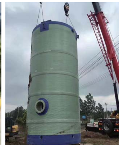
南昌万年工业园 日处理量：1250m³/D 泵站规格：DN2000*4800
