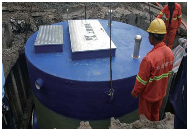
昭通瀑布泵站武 日处理量：57600m³/D 泵站规格：DN3800*7250
