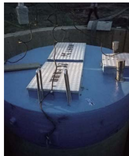
铜陵国祯环保雨水泵站 日处理量：50000m³/D 泵站规格：DN3800*8600
