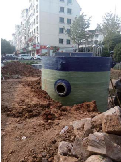
如东灯塔小区泵站 日处理量：2160m³/D 泵站规格：DN2500*4130
