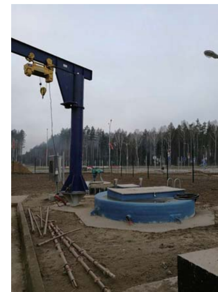
中白工业园区雨水泵站 日处理量：5860m³/D 泵站规格：DN3000*9380
