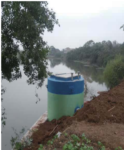
衡阳河水整治 日处理量：9600m³/D 泵站规格：DN3000*6500
