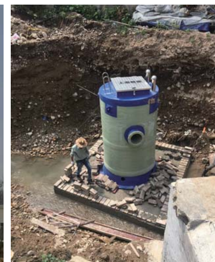
兴化城南污水处理泵站 日处理量：20160m³/D 泵站规格：DN3000*7055
